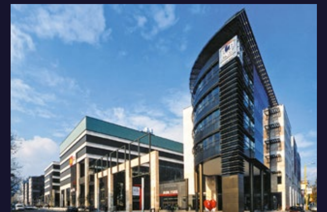
Neue Länder: In Budapest entwickelt die Bayerische Hausbau ein ganzes Stadtquartier neu, den MOM-Park.
